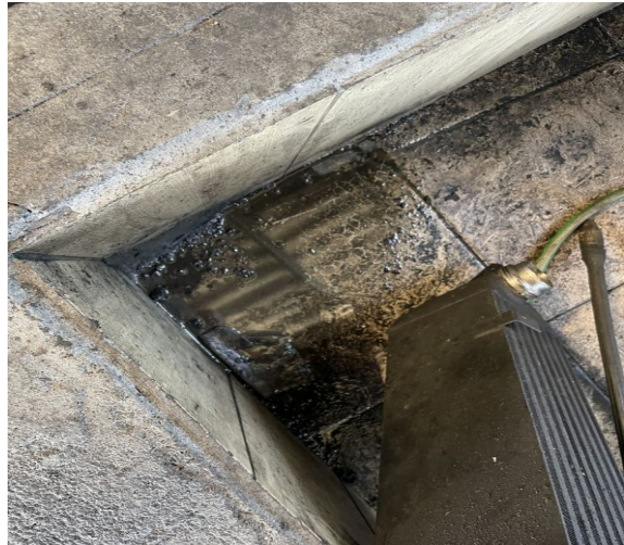
Bac de rétention maçonné refermé.
