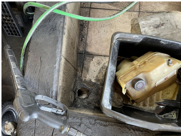
Situation au 22/01/2025 : Bac de rétention maçonné percé en partie basse.
